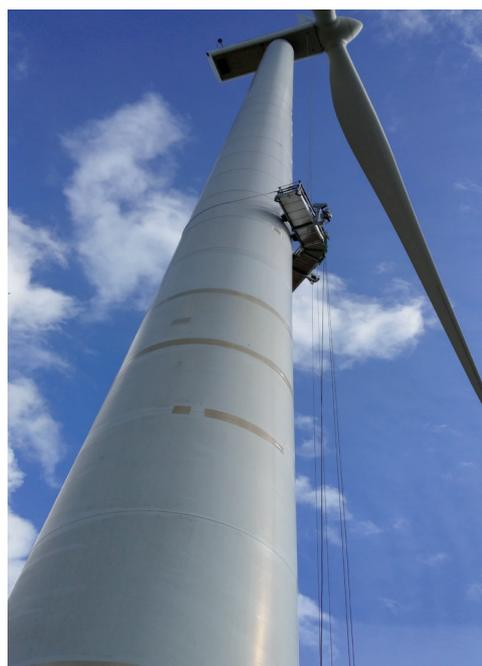
La plateforme en V a été conçue pour réaliser des travaux sur fûts d'éoliennes Ø 4-5 mètres
