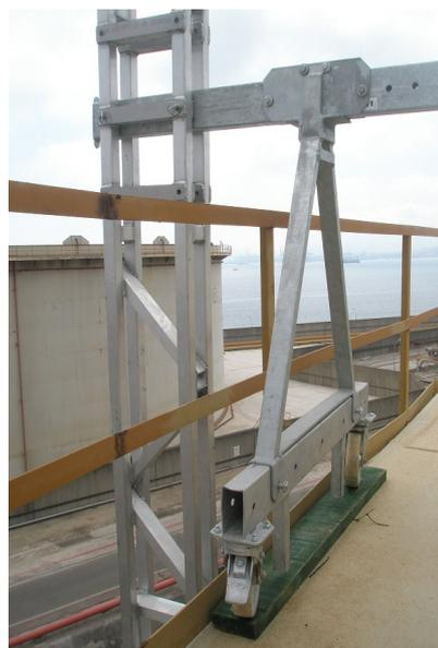
La console sous plomb se fixe sur l'élément avant d'une poutre de suspension FIXAPOUTRE placée à l'horizontale. La poutre doit être préalablement installée.
