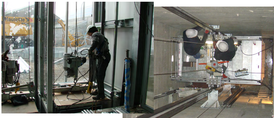
Anticaída de cargas SECURICHUTE (obligatorio en el marco de elevación de personas) con pinzas y contrapeso para el cable de seguridad*
